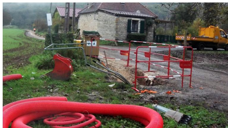
Enfouissement et renforcement des lignes électriques (moyenne tension), entre Pantalinat et La Martinie (450 m de tranchées)
