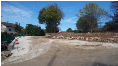
À Rul, mur de soutènement et élargissement du croisement
