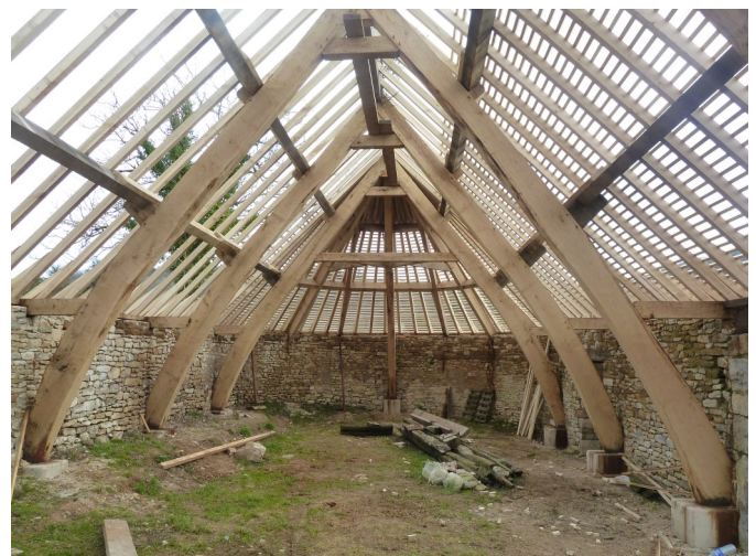
La grange en cours de restauration (janvier 2015)
