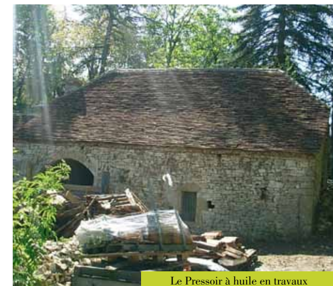
Le Pressoir à huile en travaux
