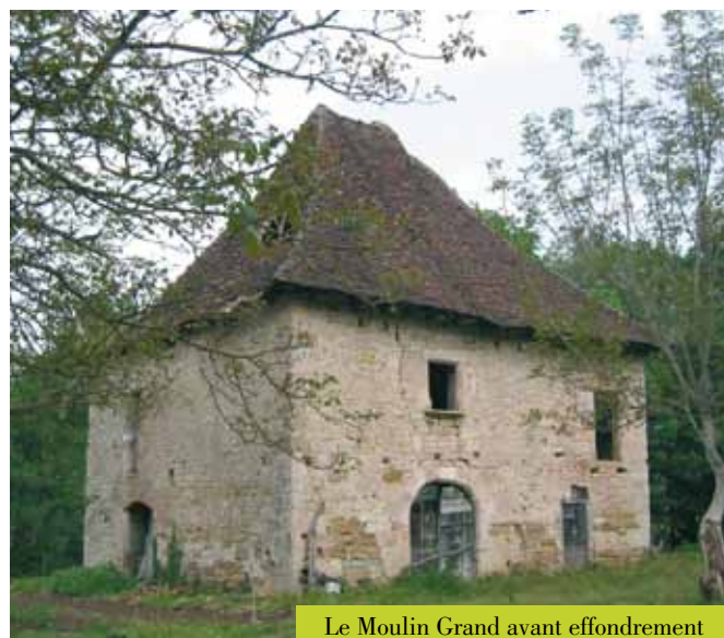
Le Moulin Grand avant effondrement
