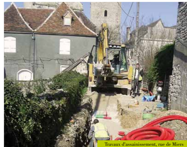
Travaux d'assainissement, rue de Miers
