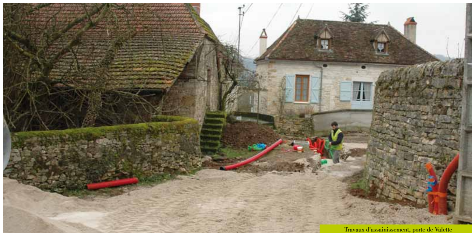
Travaux d'assainissement, porte de Valette
